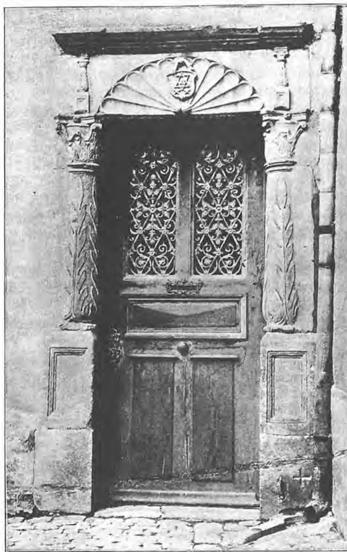
PORTE DE LA TOUR. MAISON DE GLERESSE
